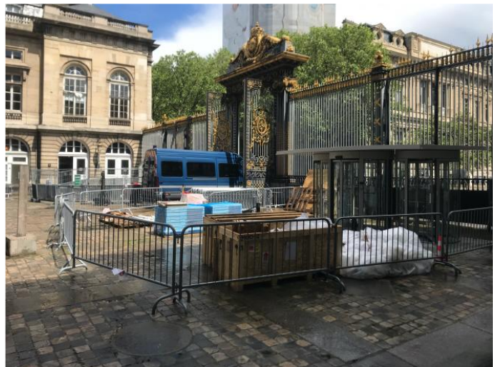
Cour d'appel de Paris, juin 2021. Installation de nouveaux portiques de sécurité au niveau de l'entrée publique. Photo : Antoine Mégie
